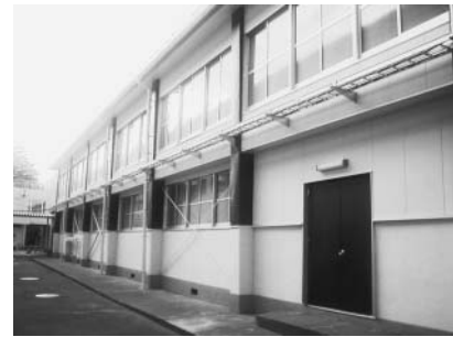
▲大磯中学校体育館耐震改修事業
