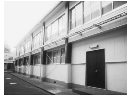
▲大磯中学校体育館耐震改修事業
