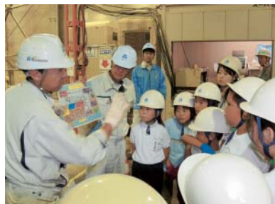
⑥大磯小学校4年生下水道工事現場見学 (10/8)
