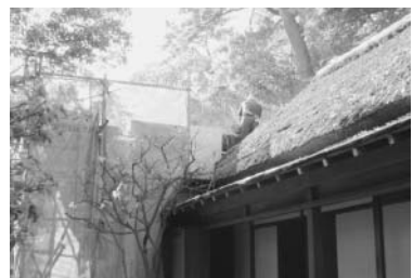
▲改修中の鳴立庵
