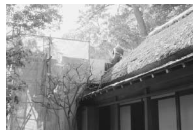
▲改修中の鳴立庵
