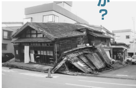
▲地震で1階が崩れた建物
