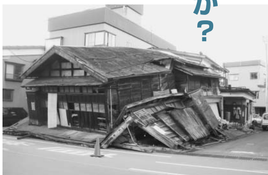
▲地震で1階が崩れた建物
