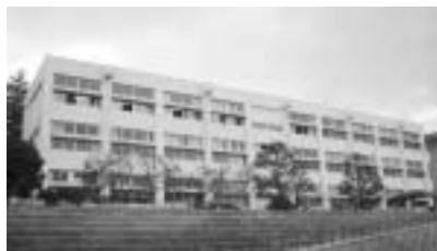
大磯中学校2号館
