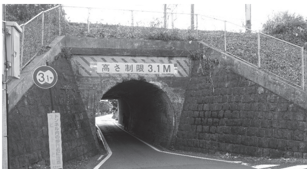
図2 北側からみた押切架道橋
