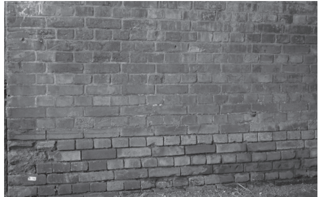
図5 側壁のイギリス積み
