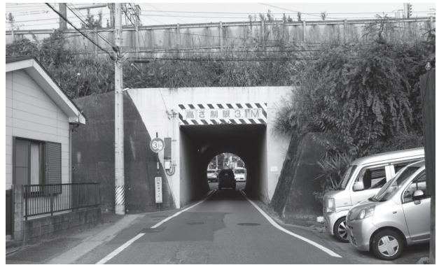
図4 南側からみた押切架道橋
