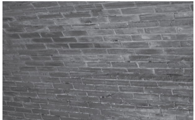
図6 側壁から天井部の長手積み
