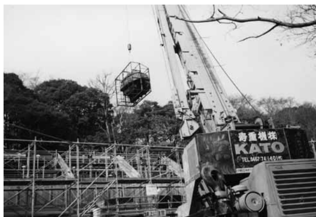
工事中の郷土資料館（1988年）
