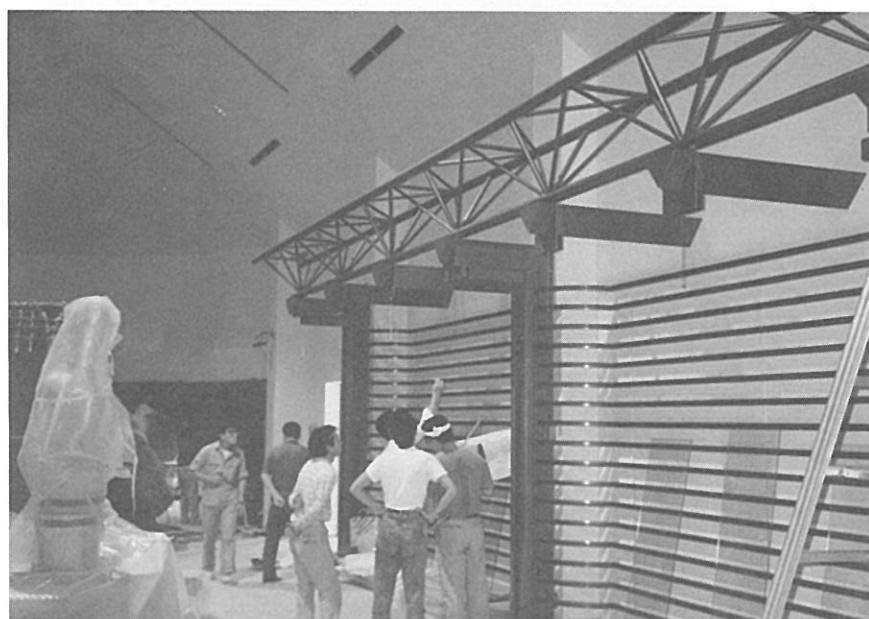
常設展示室 展示ポーター取付
