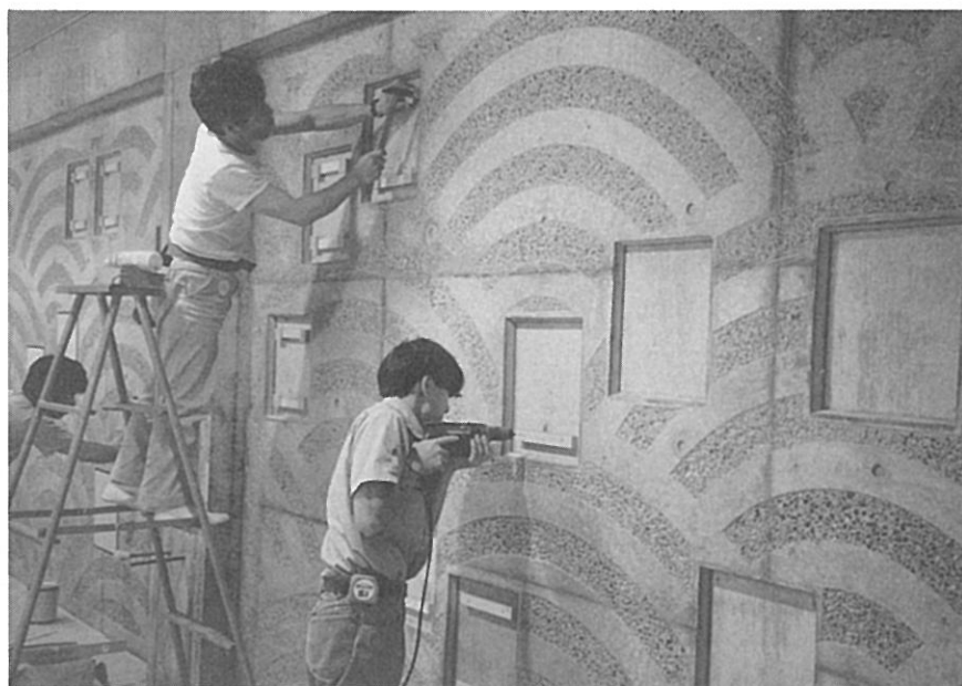
展示ホール エッチング加工板取付
