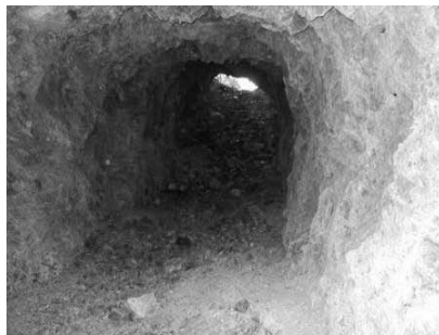
写真4 実測図E付近より東側を望む
