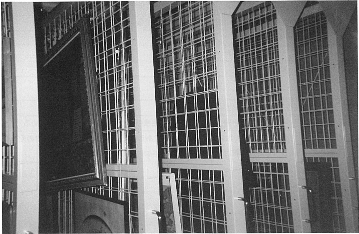
◇ 絵画ラック設置工事
