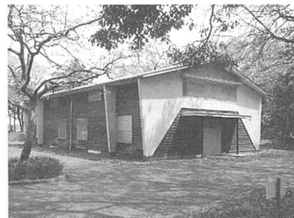
(B区)畜舎(平成19年4月15日撮影)
