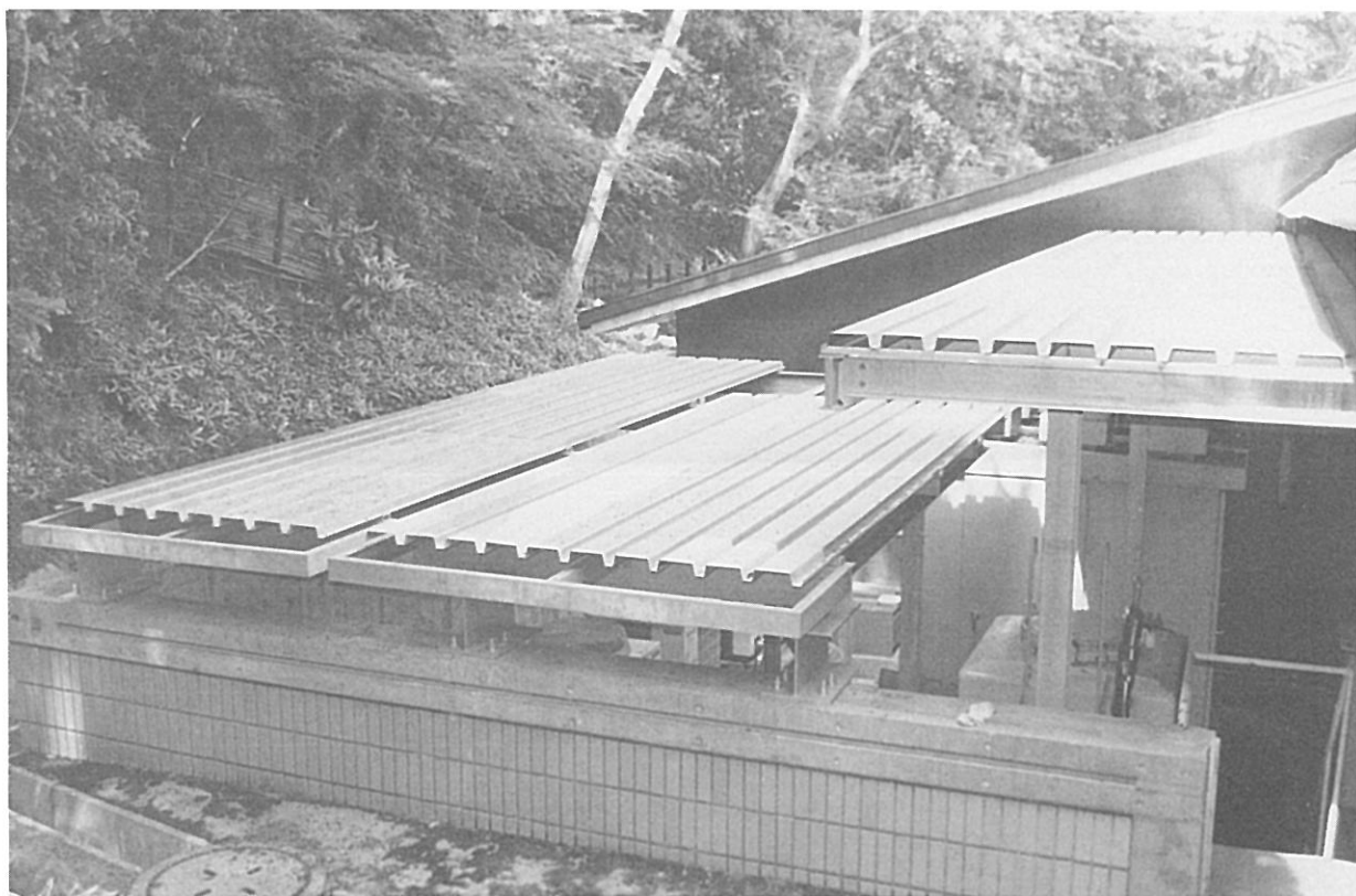
屋外機置場整備工事
