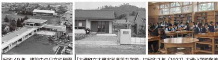
昭和49年、建設中の月京幼稚園。
