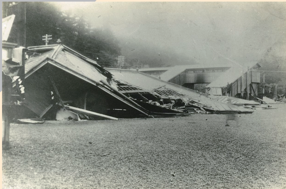
倒壊した大磯駅の駅舎
