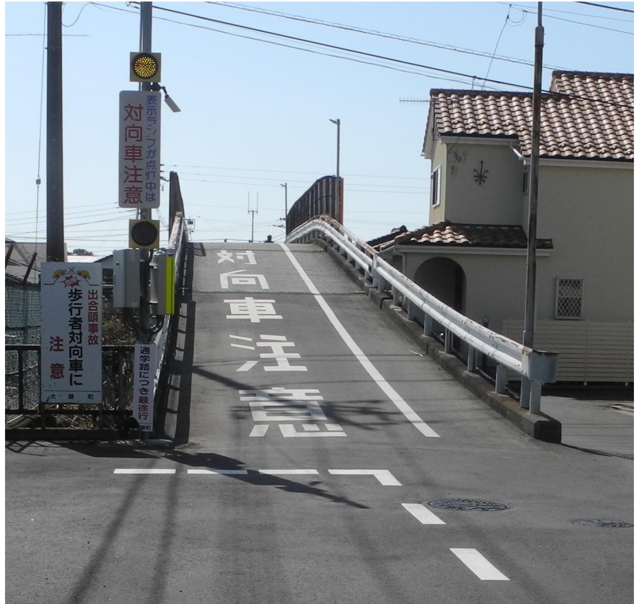
長寿命化に向けた修繕を行う日吉跨線橋
