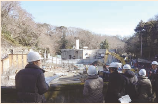
2月10日 総務建設常任委員会行政視察（仮称）リサイクルセンター建設現場を見学。
