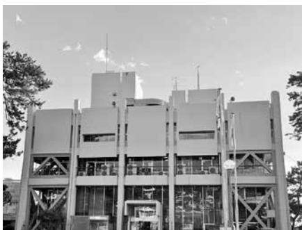
この地に建設！
