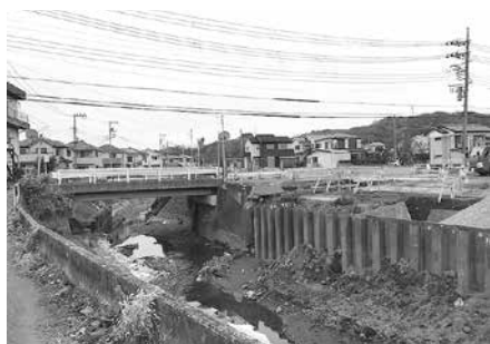
現在工事中の国府橋
