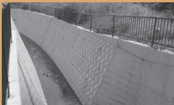
治水及び浸水対策のため、延長47mにコンクリート積による護岸整備を行った。
