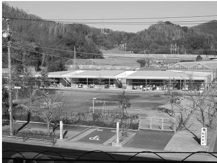
スペースのある幼稚園の屋根
