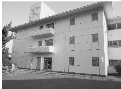
大磯中学校3号館
