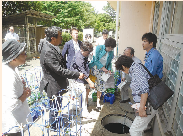
5月22日 福祉文教常任委員会現地確認 大磯小学校灯油配管破損状況を確認、早急に対策を
