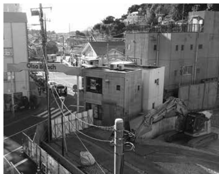
取り壊した旧駐輪場跡地と駅前広場
