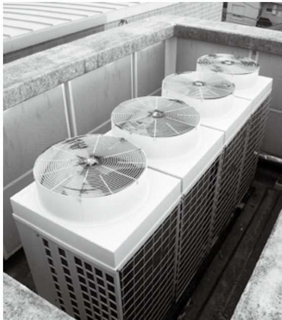
老朽化した空調設備の室外機
