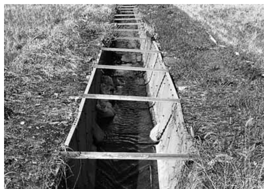
改修予定の西小磯農業水路
