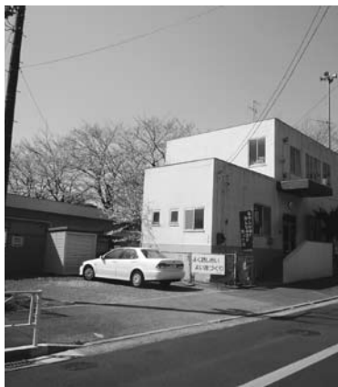
石神台汚水処理施設と会館
