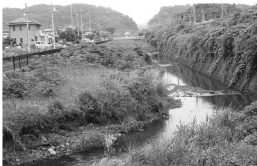
土砂が堆積し雑草が茂っている不動川
