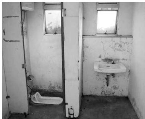
町公衆トイレの現状
