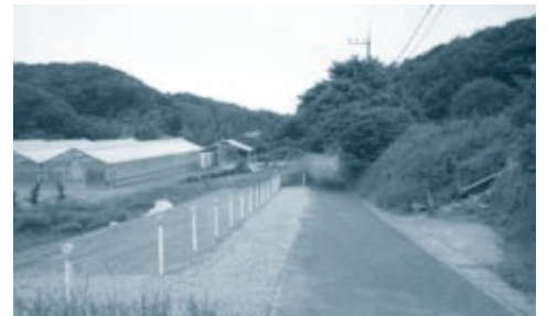
国府本郷西小磯1号線(マリア道)拡幅部分
