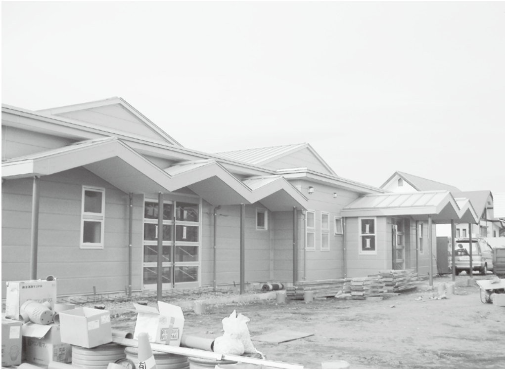
完成間近の子育て支援総合センター
