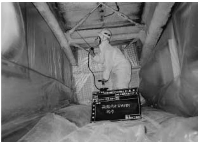
ふれあい会館 アスベスト除去作業
