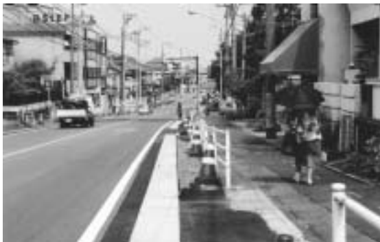
電線の地中化工事
