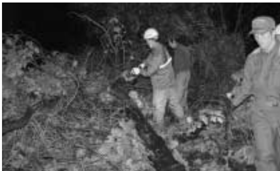
台風の復旧工事
