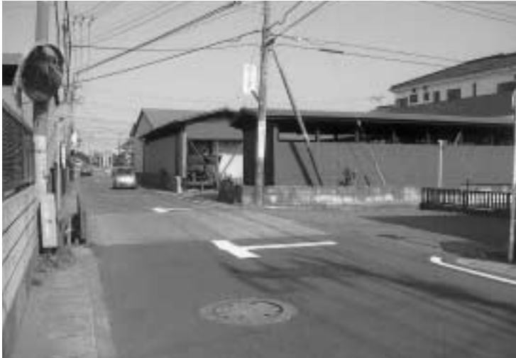
東町・浜岳川付橋付近
