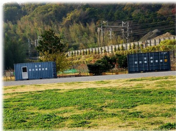
「西の池跡公園の地区防災備蓄倉庫」
