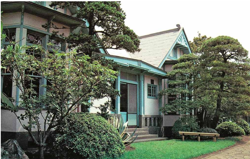
① 洋室部分の外観。
