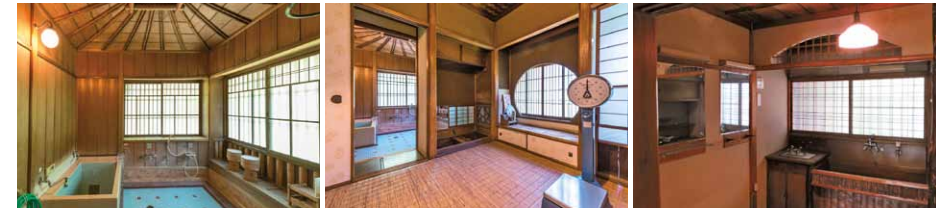
⑧ 浴室 換気機能のある天井。⑨ 脱衣室 窓は曇りガラスを使用。⑩ 洗面所。
