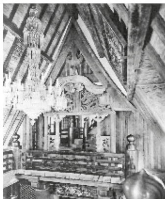
広間吹抜部(廻廊)
