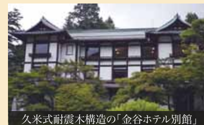
久米式耐震木構造の「金谷ホテル別館」
