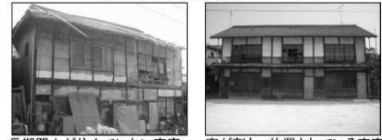
長期間人が住んでいない空家
