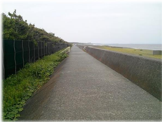
「高潮・津波に備える防潮堤」
