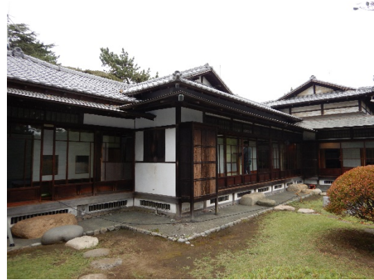
写真20 外観（2018年10月撮影）
