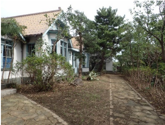
写真 4 洋室棟南側外観 （2018 年 10 月撮影）
