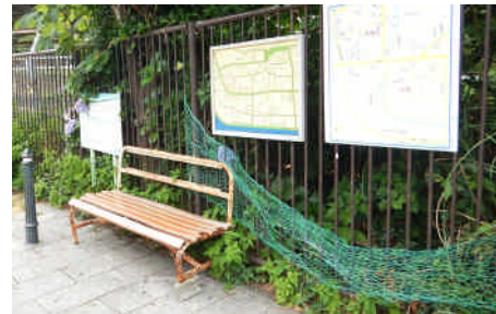
⑪ 老朽化したベンチ
