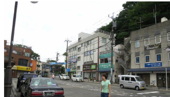
⑧ 大磯駅の正面に立ち並ぶ商業ビルファサード
