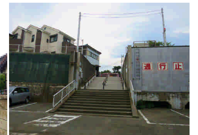
⑩ 避難経路。大磯港の第1駐車場からの避難経路が階段となっている
