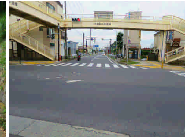
② 大磯駅入口交差点の様子。歩道橋があるが、平成10年に横断歩道・自転車横断帯が設置された。
