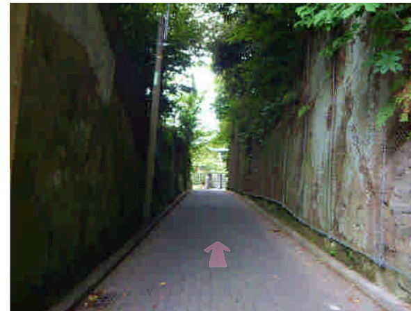
④ 愛宕神社脇の切り通し。岩肌剥き出しの壁に挟まれた特徴的な空間となっている。写真方向へ一方通行
