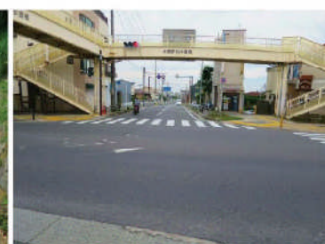
② 大磯駅入口交差点 歩道橋と横断歩道の両方がある。
