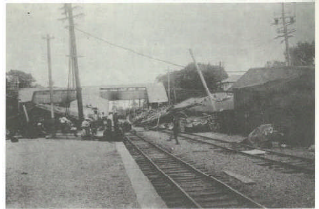
駅舎の被害状況（大正12年）
