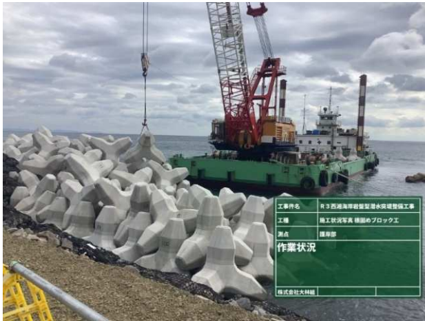
消波ブロック据付
