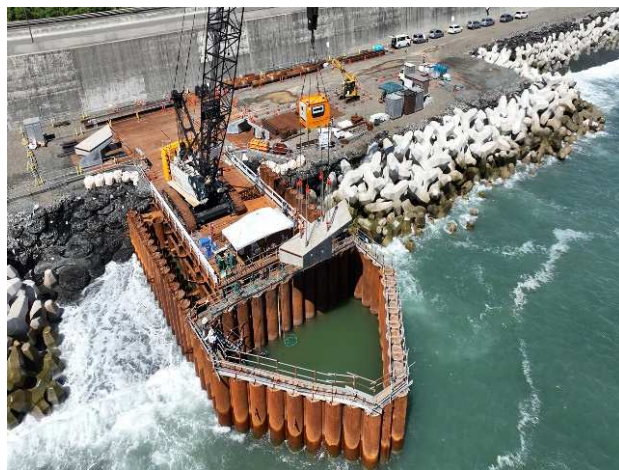
プレキャストブロック据付
