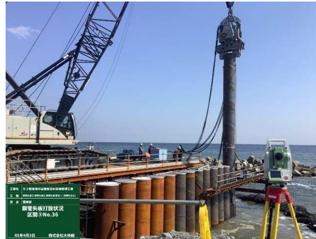
鋼管矢板打設
