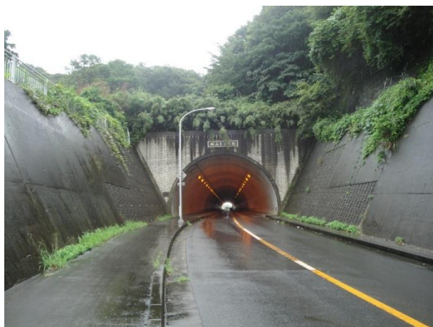
城山トンネル
