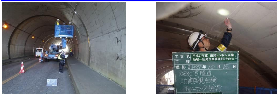
写真 5-1 トンネル点検状況
