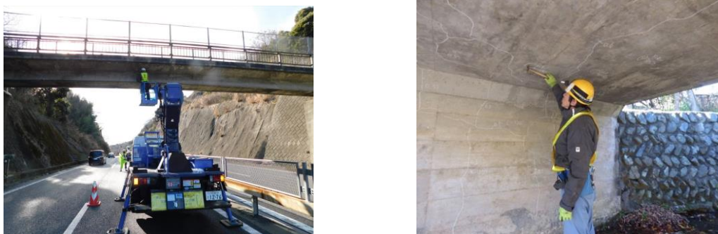
写真6-1 橋梁点検状況
