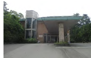
写真 11③(旧)バンケットホール 北側外観（2018 年撮影）
