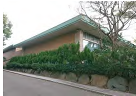
写真 88 (旧) パンケットホール
