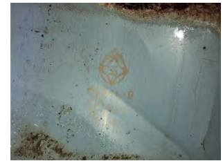
写真 53 後補屋根材 JIS (2019 年撮影)
