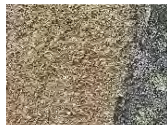
写真 56 薄塗石肌調仕上げ (2019 年撮影)
