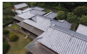
写真 69 高さの異なる屋根を組み合わせた複雑な屋根構成 (2019年撮影)
