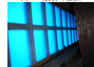
写真 51 破風に取りつく格子窓の摺りガラス（2019 年撮影）
