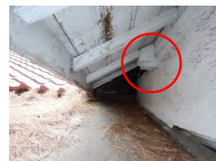
写真43 梁先端部木鼻 (2019年撮影)
