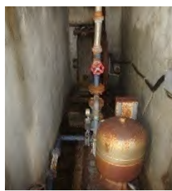
写真 58 ポンプ室内 (2019 年撮影)
