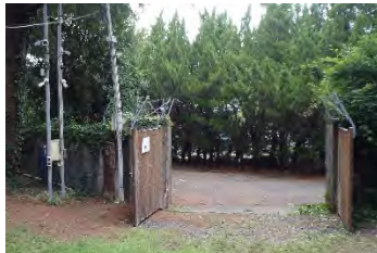
写真 22①門扉・ポンプ室（2018年撮影）
