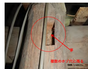
写真 64 ほぞ穴内部に残る茅材破片（2019 年撮影）
