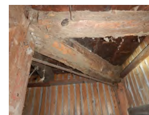
写真 66 緊結鉄筋棒（2019 年撮影）
