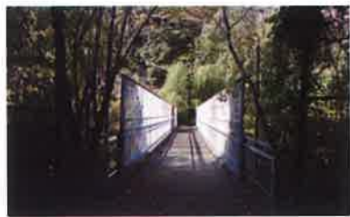
写真1 下吉沢架道橋 2023年12月7日撮影
