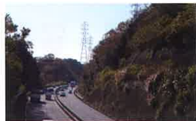
写真3 小田原方面を見る 2023年12月7日撮影
