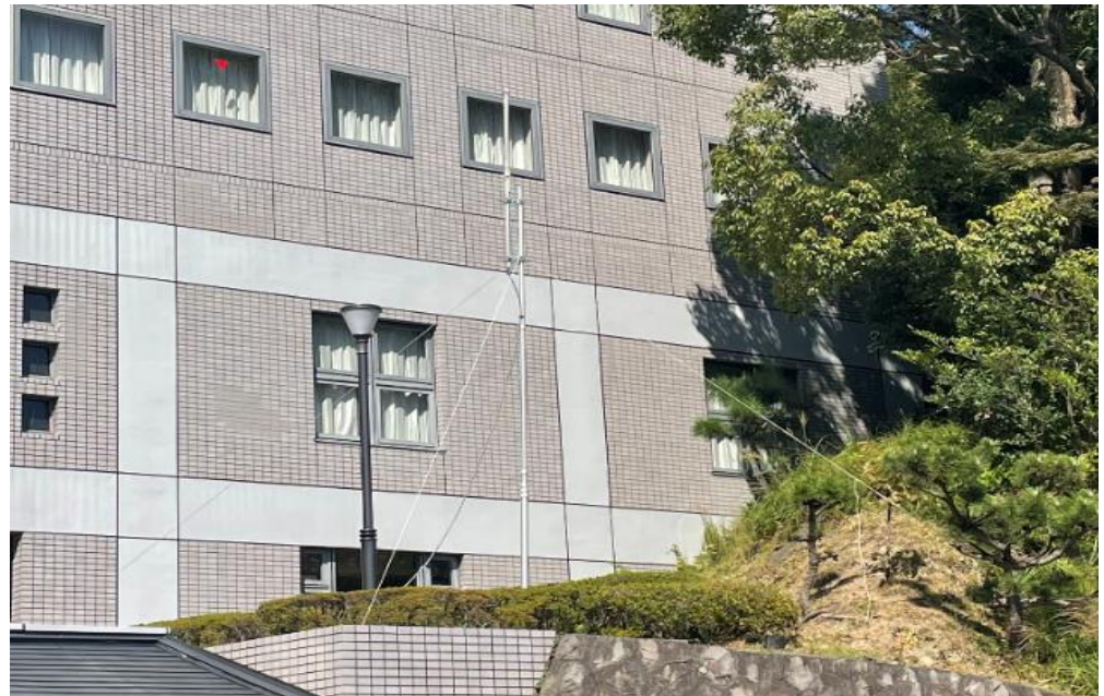
仮設アンテナ
